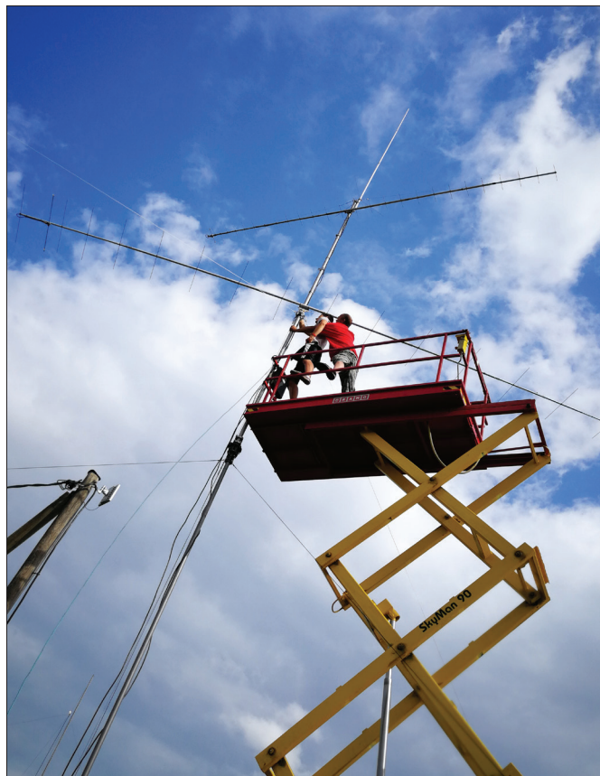
Pika 2m yagi paigaldamine tõstukilt
